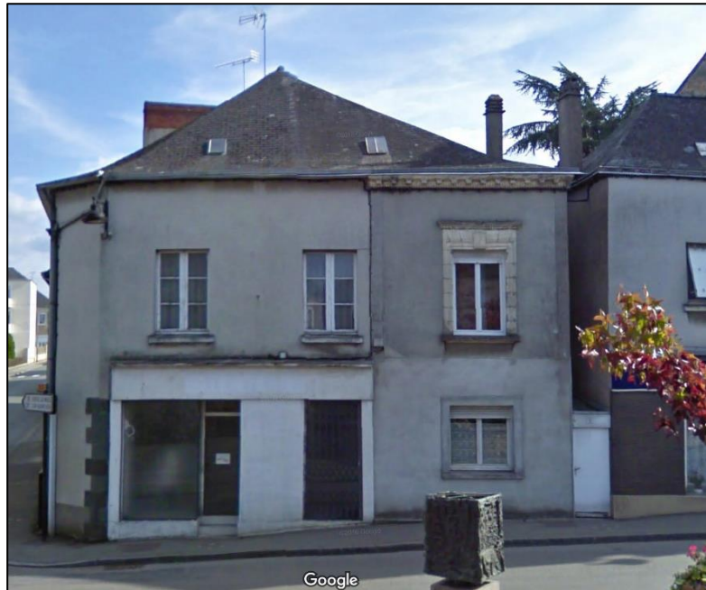
A gauche de la photo, l'immeuble de la parcelle AL 1 (avec la vitrine). A droite, l'immeuble de la parcelle AL 91 (avec la corniche)
