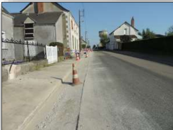
■ Enfouissement des réseaux électriques rue de la Frénoise
