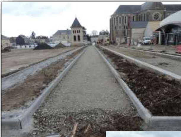
■ Aménagement de la partie haute de la rue de la Poste
